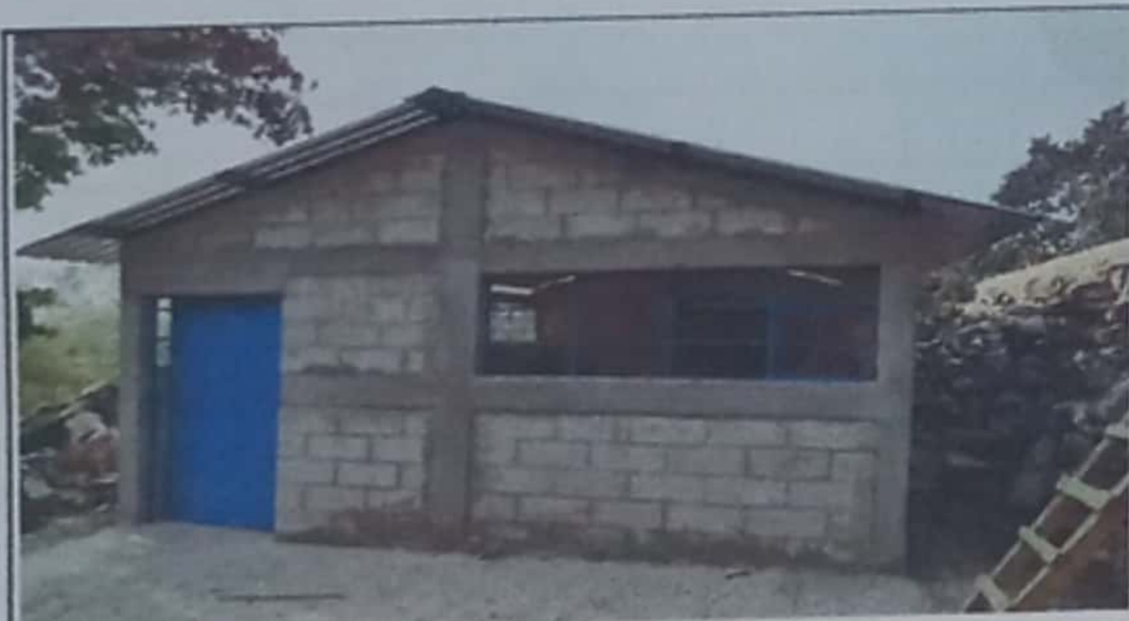
Foto 5: INSTALACION DE ESTRUCTURA METALICA Y CUBIERTA DE LAMINA
