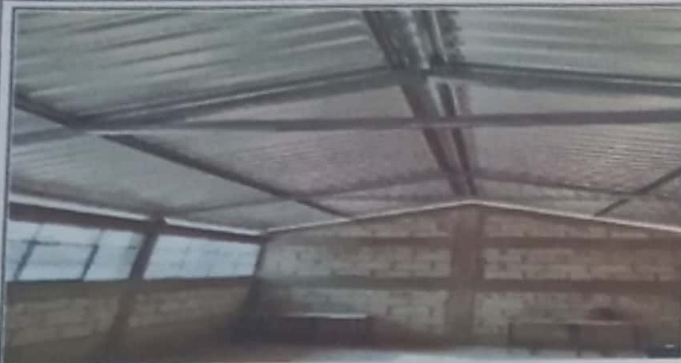
Foto 1: FINALIZACION DE LA INSTALACION ESTRUCTURA DE TECHO
