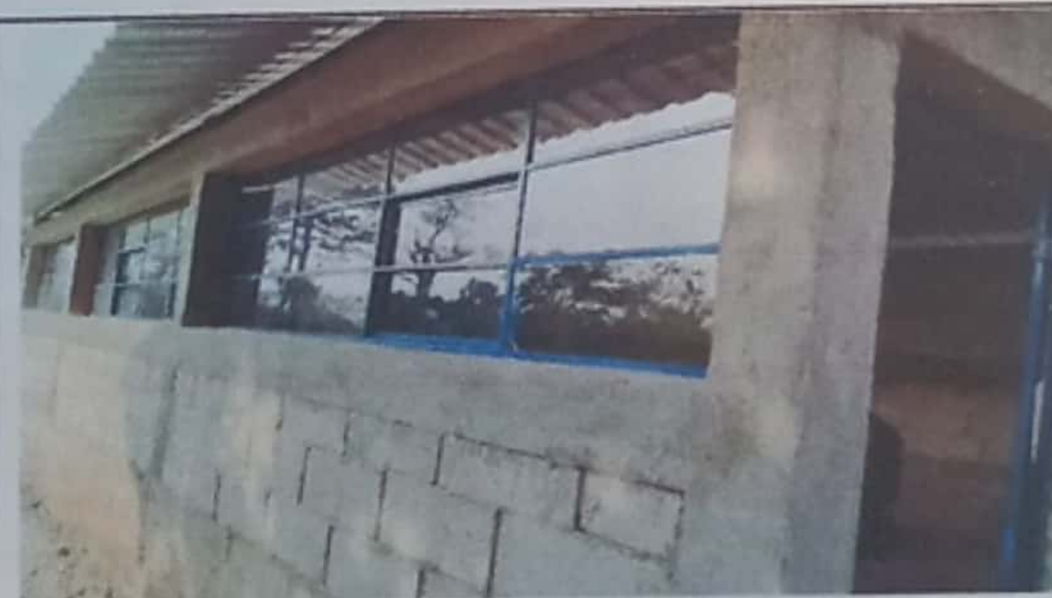
Foto 6: FINALIZACION DE INSTALACION VIDRIOS Y VENTANAS
