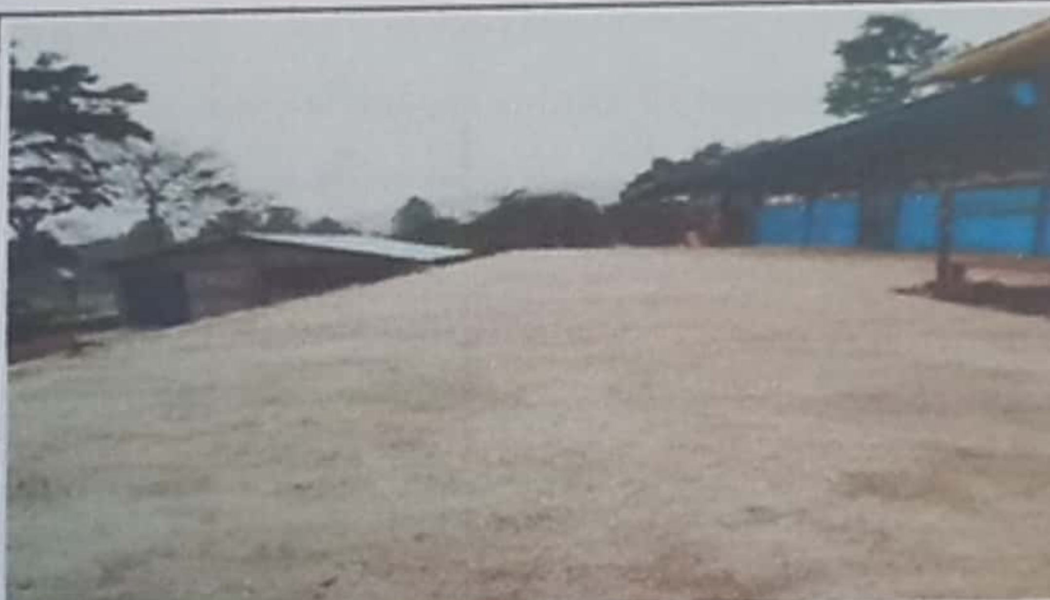
Foto 4: FINALIZACION LOSA DE PATIO
