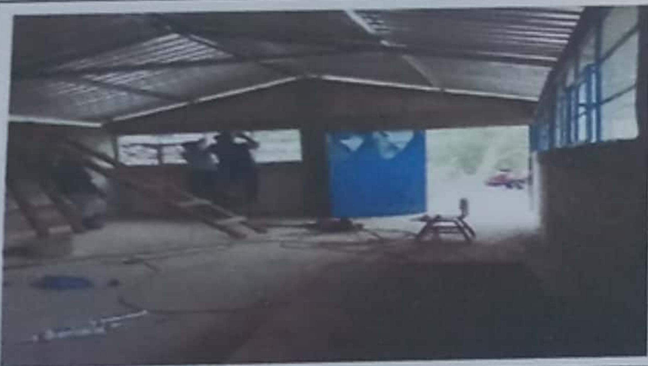
Foto 3: FINALIZACION DE INSTALACION DE PUERTAS Y VENTANAS
